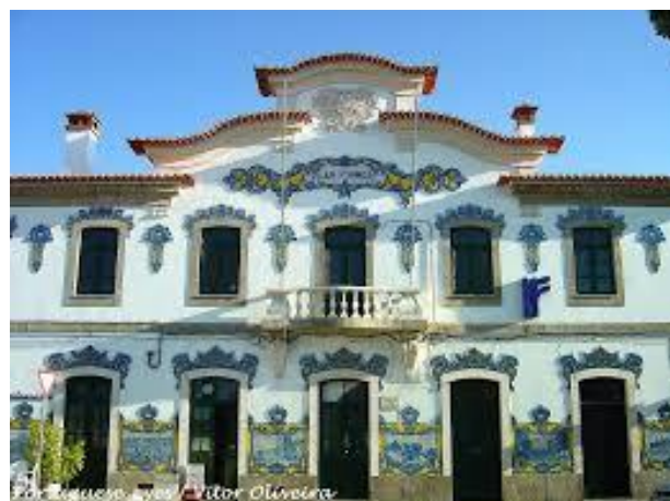
Figura 5 – Estação Ferroviária – Vilar Formoso
